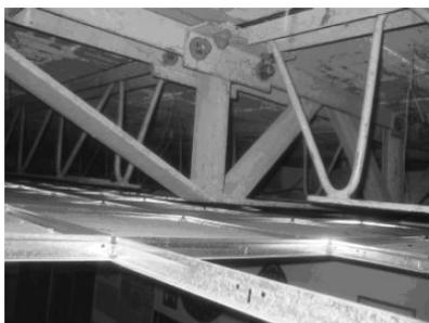
Figg. 6-7 - Dettaglio del sistema costruttivo con in evidenza la trave reticolare e la trave Joist (orditura secondaria).
