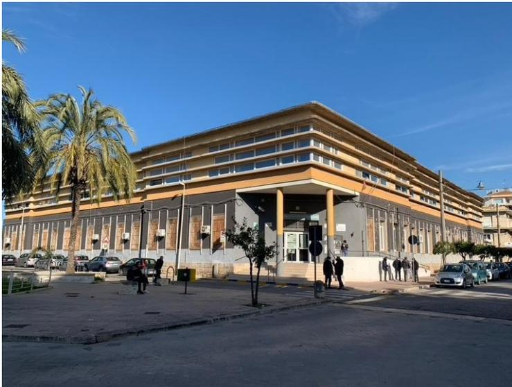
Dalla Scheda di Sintesi della Verifica sismica di Livello 2 redatta in data 20/11/2020 dalla Dott. Ing. Cettina Buccheri si evince un Indicatore sismico allo SLV pari a 0.10 e quindi nettamente inferiore all'unità.
