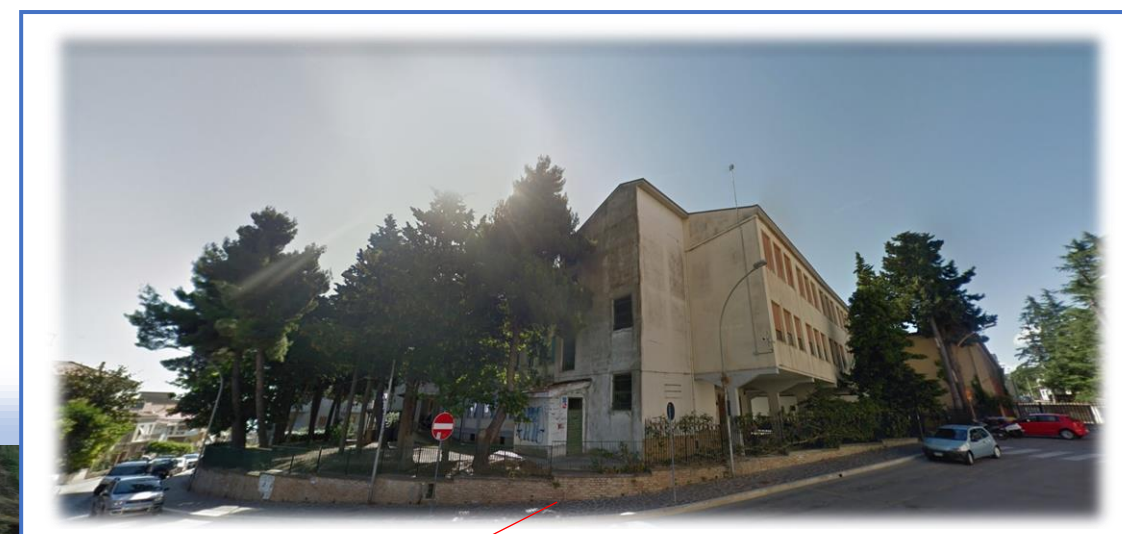
Vista edificio scolastico angolo Via Madonna dell'Asilo e Via dei Conti Ricci
