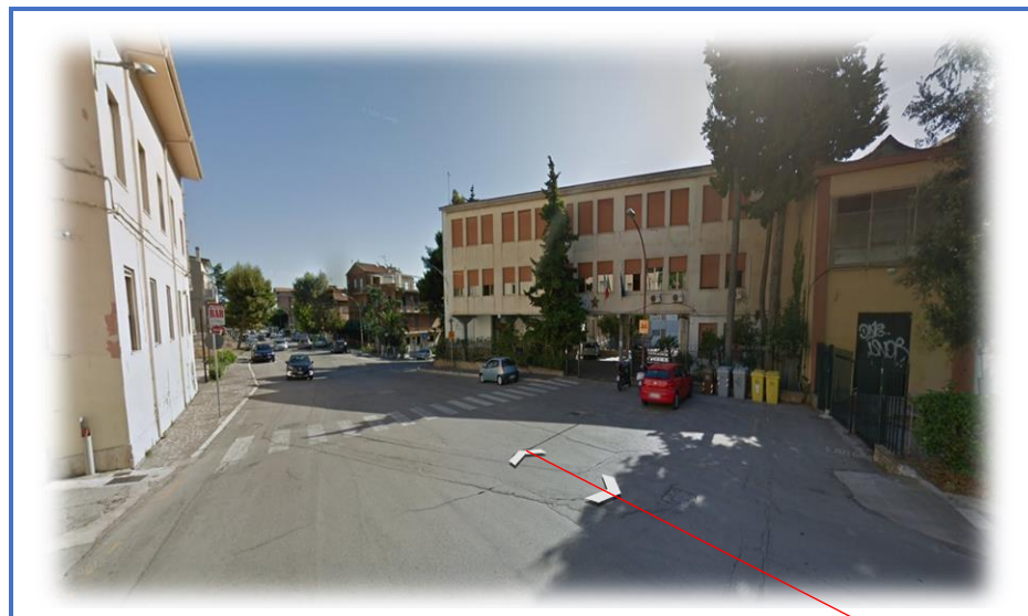
Vista Frontale edificio scolastico da demolire
